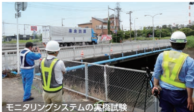
モニタリングシステムの実橋試験
