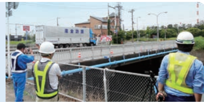
モニタリングシステムの実橋試験
